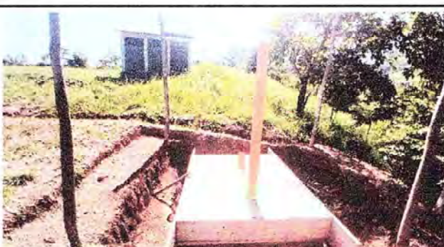
Foto 6: Rehabilitación de fosa séptica.
