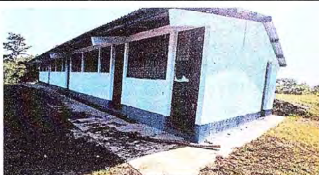
Foto 5: Vista frontal de la escuela.
