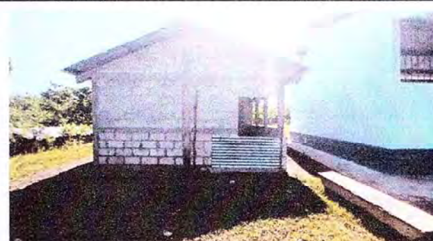
Foto 4: Mejoramiento de cocina.
