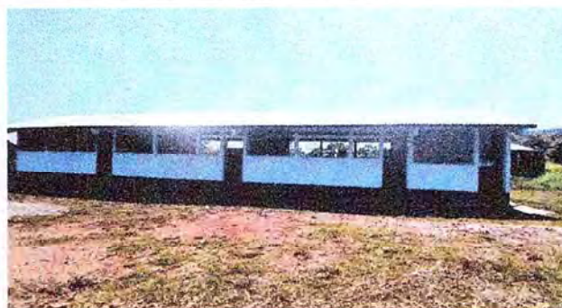
Foto 2: Mejoramiento de Pintura.
