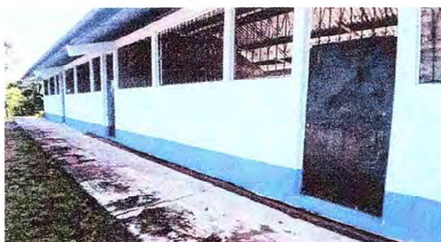
Foto 3: Reparación de puertas.
