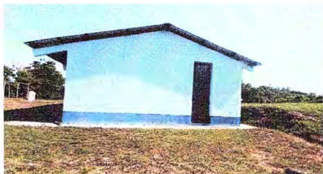
Foto 1: En esta fotografía se muestra el mejoramiento de techo.
